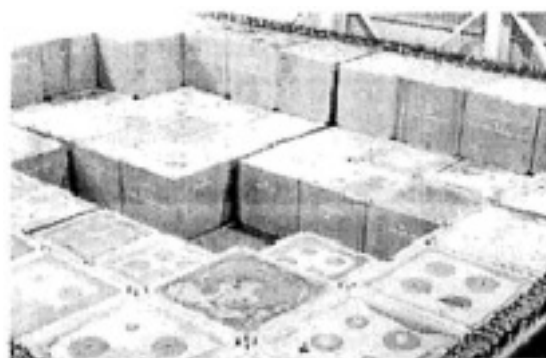
図3 LILW用コンクリートコンテナ（エルカブルル処分場）
